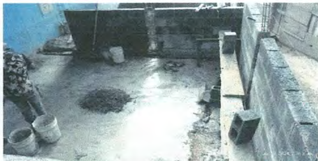
Foto 1: Mejoramiento modulo de cocina.
