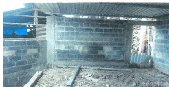
Foto 4: Mejoramiento modulo de corredor.
