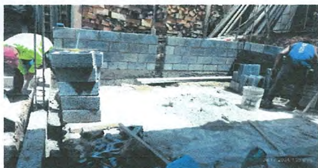
Foto 3: Mejoramiento modulo de cocina.
