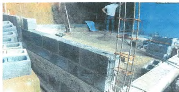
Foto 4: Mejoramiento modulo de cocina.
