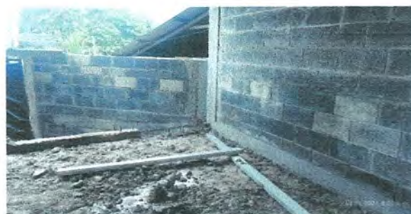
Foto 2: Mejoramiento modulo de corredor.
