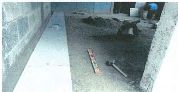
Foto 3: Mejoramiento de piso (Ceramico de alto impacto)
