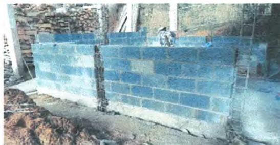
Foto 2: Mejoramiento modulo de cocina.
