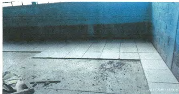
Foto 2: Mejoramiento de piso (Ceramico de alto impacto)
