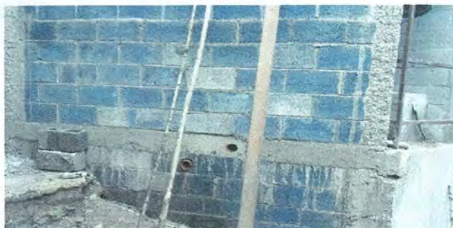
Foto 3: Mejoramiento modulo de corredor.
