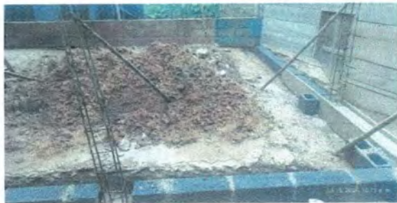
Foto 1: Mejoramiento modulo de corredor.
