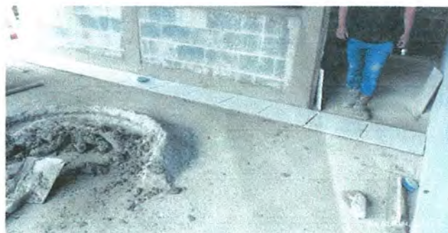
Foto 4: Mejoramiento de piso (Ceramico de alto impacto)
